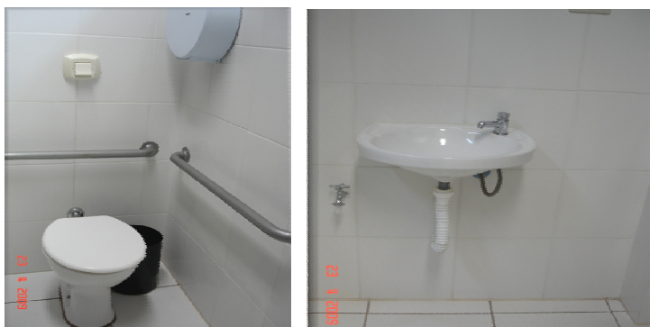
Figura 07 – Sanitário adaptado ao PNEs.
