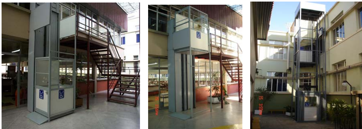
Figura 06 – Fabricação e instalação de elevadores para cadeirantes nos Campi da UTFPR.
