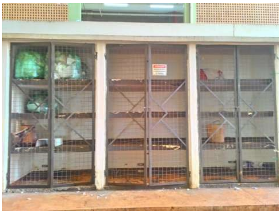
Figura 04: Vista frontal da ATT de resíduos recicláveis.
