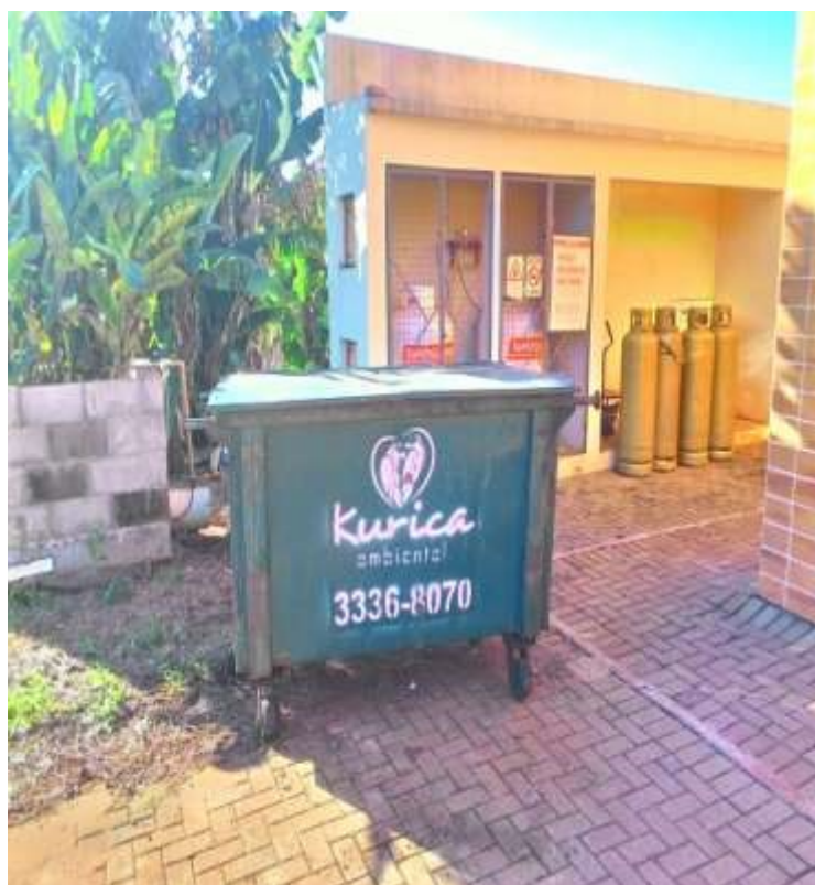
Figura 02: ATT de Rejeitos.
