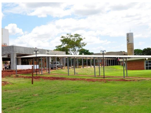
Figura 25 – Execução de cobertura de acesso blocos
