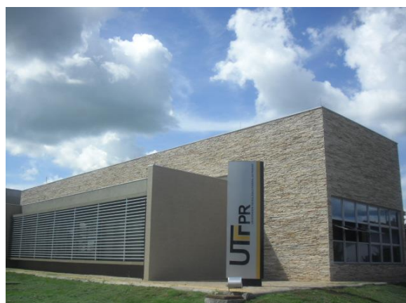
Figura 22 – Construção do Bloco K/setor administrativo
