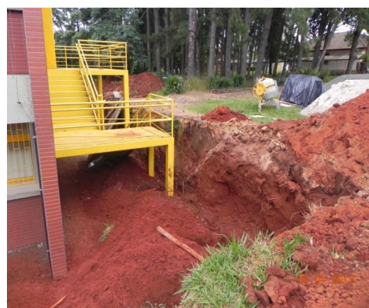
Figura 30 – Construção do muro de arrimo Bloco L
