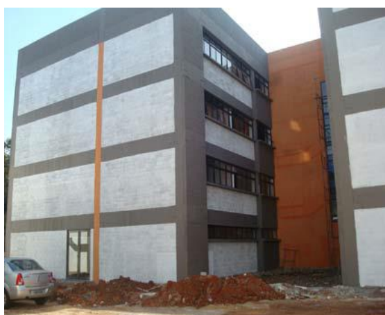
Figura 19 – Construção Bloco EF – Sede Ecoville
