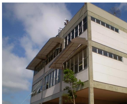
Figura 18 – Bloco CIPECA/ instalação de toldos
