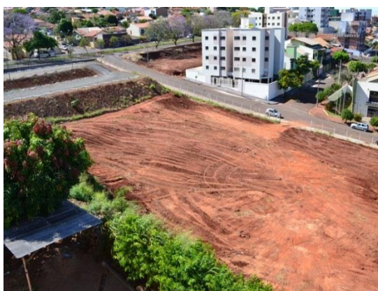
Figura 17 – Terraplenagem de terreno
