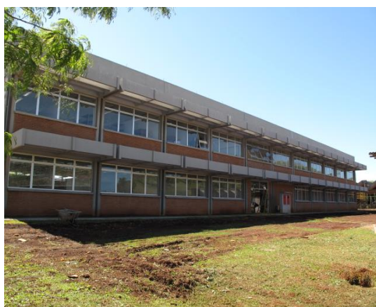
Figura 27 – Construção Bloco J1
