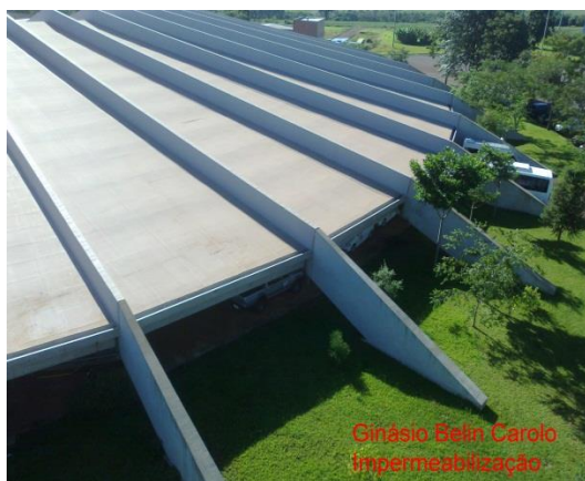
Figura 15 – Impermeabilização do Ginásio
