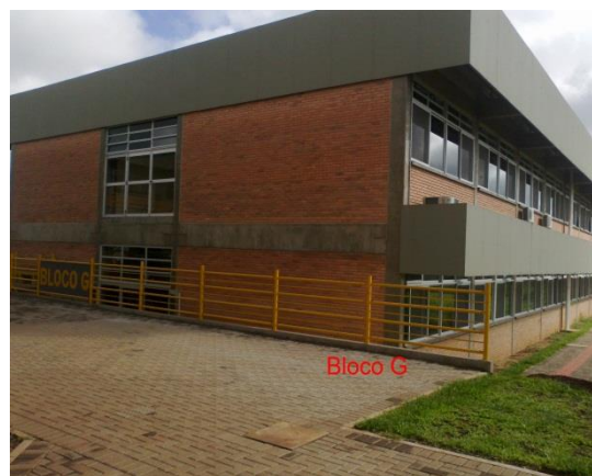
Figura 16 – Construção Bloco G
