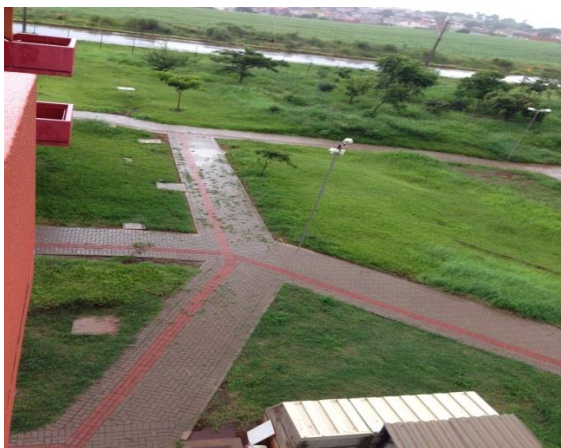
Figura 23 – Pavimentação da área urbanizada em pavers
