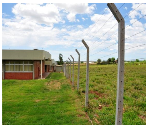
Figura 26 – Execução de cercas e paisagismo
