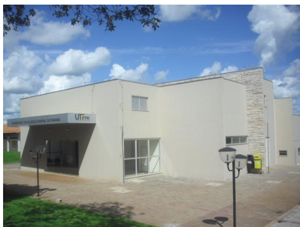
Figura 21– Construção do Bloco L/ auditório
