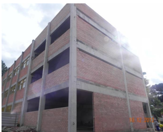
Figura 29 – Ampliação Bloco da Pós-graduação
