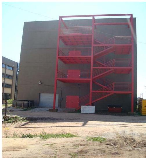
Figura 18 – Escada de emergência Bloco A – Sede Ecoville
