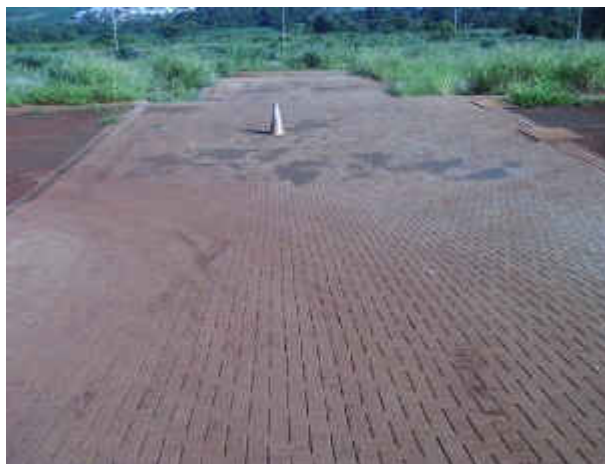
Figura A.13.1.8.1.2-H.2 – Pavimentação dos acessos ao estacionamento
