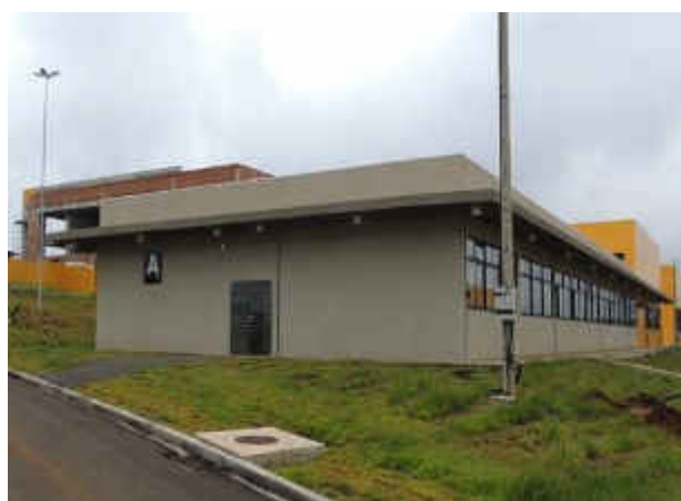
Figura A.13.1.8.1.2-G.1 – Construção do Bloco A
