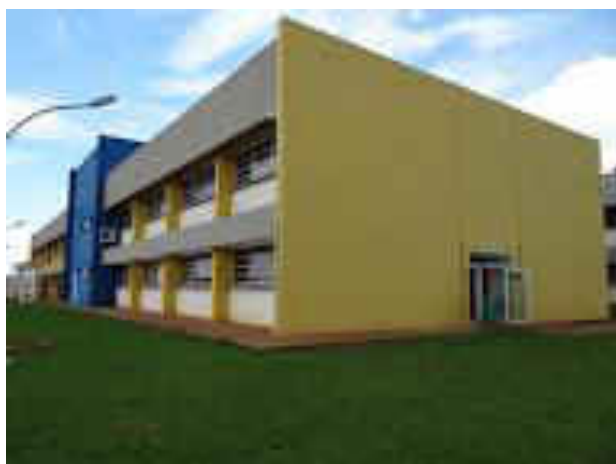
Figura A.13.1.8.1.2-A.1 – Construção do Bloco M
