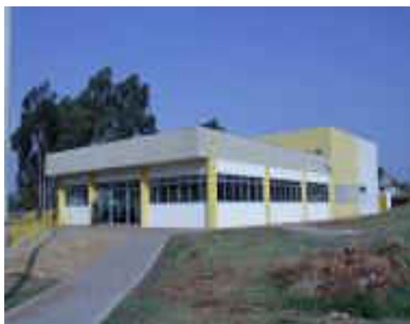
Figura A.13.1.8.1.2-A.2 – Construção do Bloco E - RU
