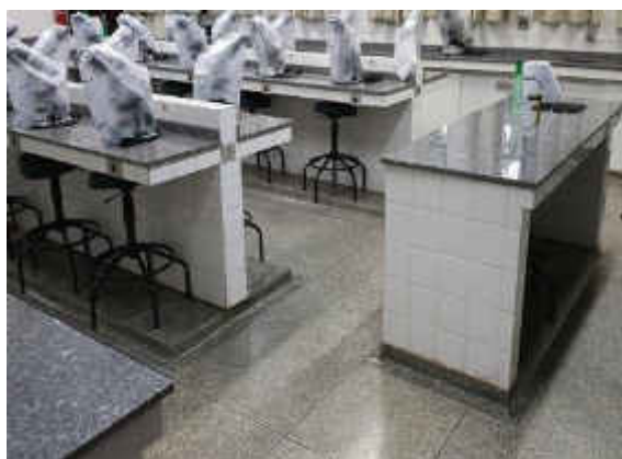
Figura A.13.1.8.1.2-L.2 – Piso de granitina em laboratório
