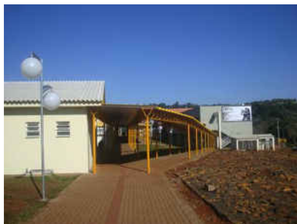
Figura A.13.1.8.1.2-F.2 – Cobertura metálica
