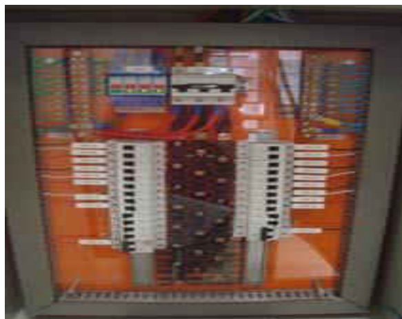
Figura A.13.1.8.1.2-D.2 – Reforma nas instalações elétricas Bloco N
