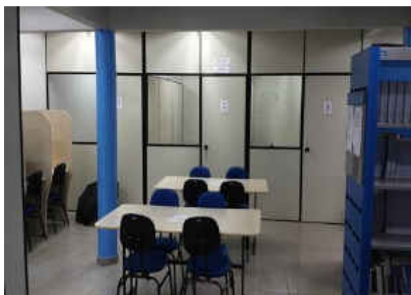
Figura A.13.1.8.1.2-L.1 – Instalação de divisórias
