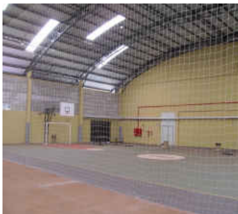
Figura A.13.1.8.1.2-M2 – Adequações no ginásio
