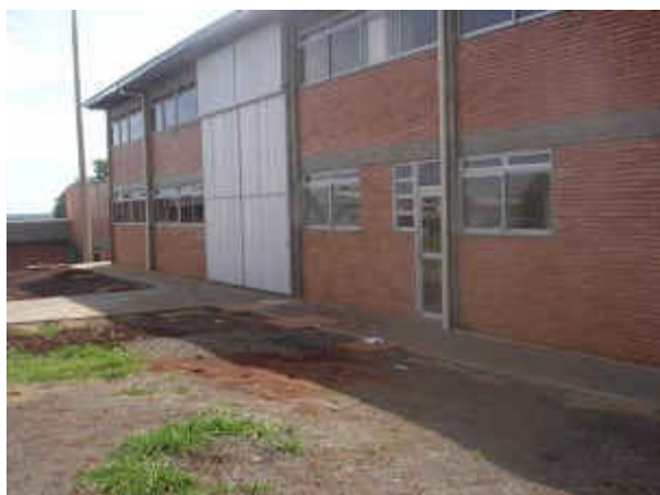
Figura A.13.1.8.1.2-B.1 – Construção da garagem
