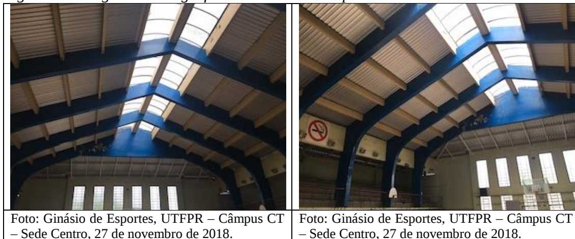
Figura 04 – Registros Fotográficos – Ginásio de Esportes
